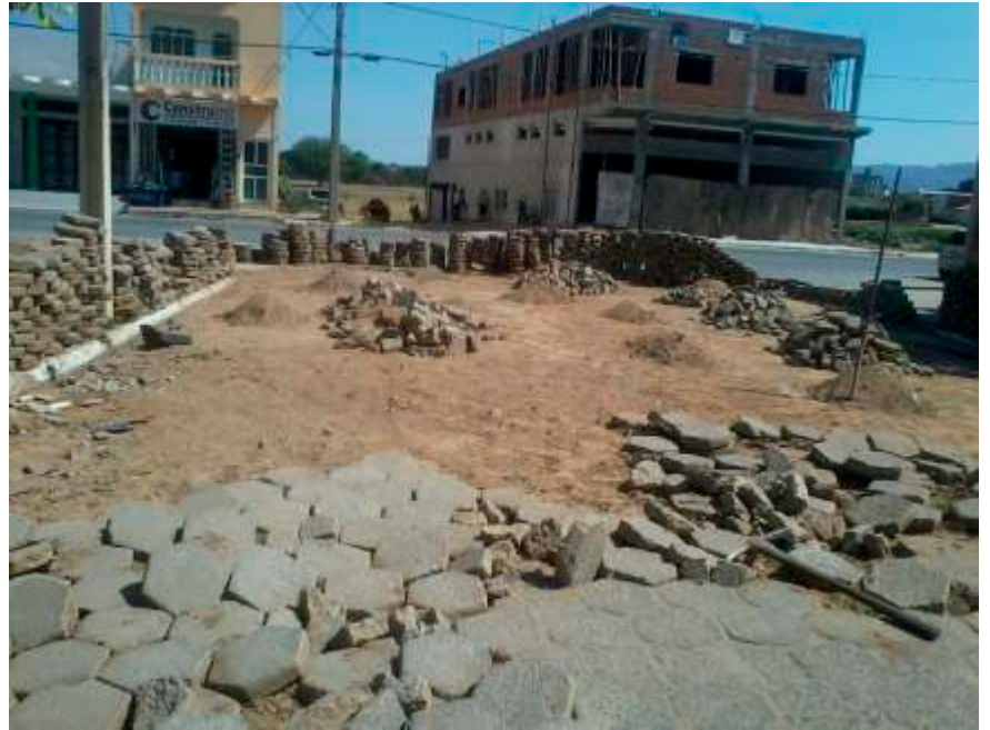
Recapeamento asfáltico da Avenida José Silveira Lopes, importante via de acesso
